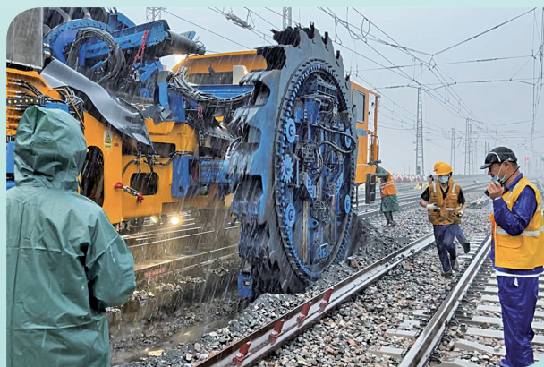
沐雨栉风·道岔清筛施工
